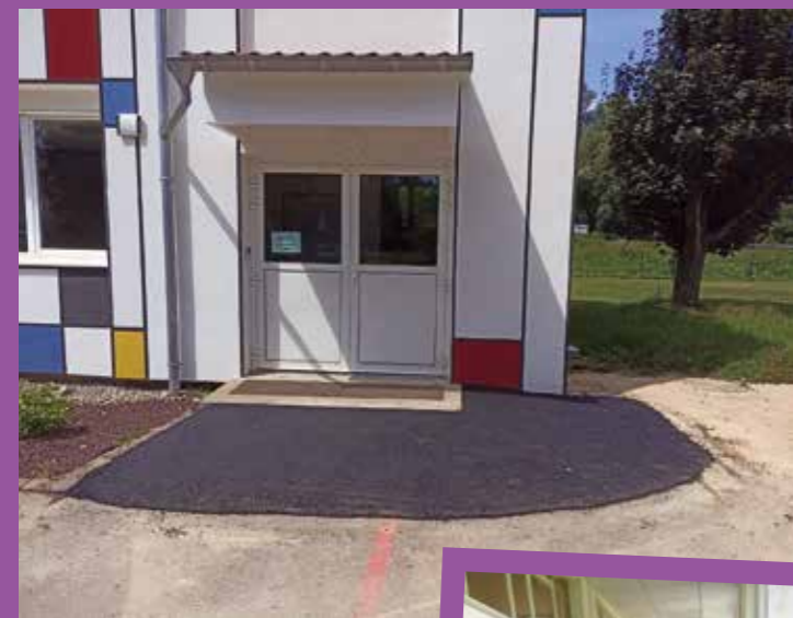
Reprise enrobés seuil de porte école élémentaire
