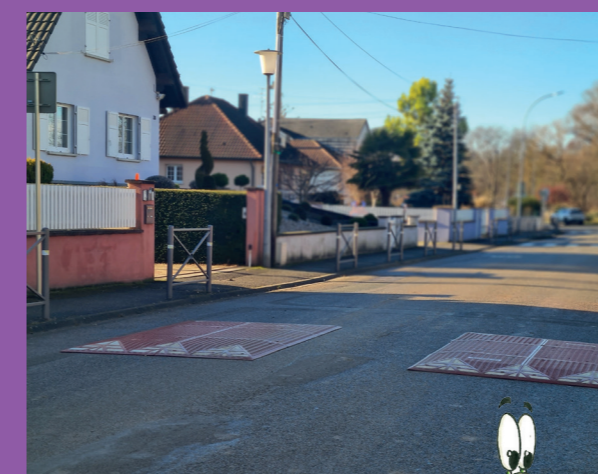
Pose de coussins berlinois dans les rues du Séminaire, du Repos et Grand'Rue
