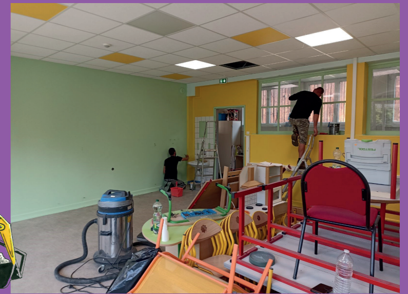
Travaux de peinture à l'école maternelle
